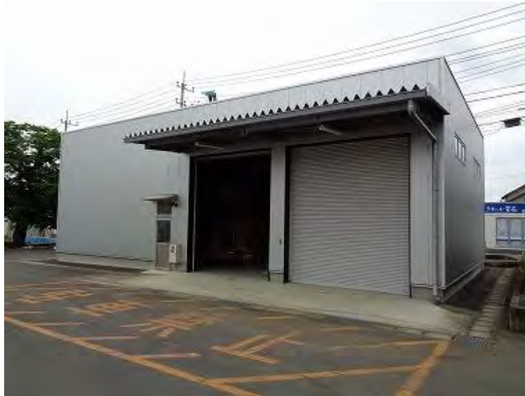
(写真は桜川市防災備蓄倉庫)
